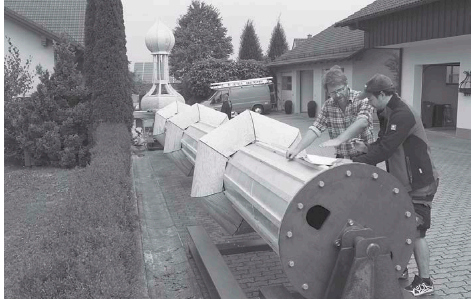
Freiham Folly , Auflattung des Holzgerüsts auf den Stahlchaft im Inneren; Copyright: Johannes Deremetz
