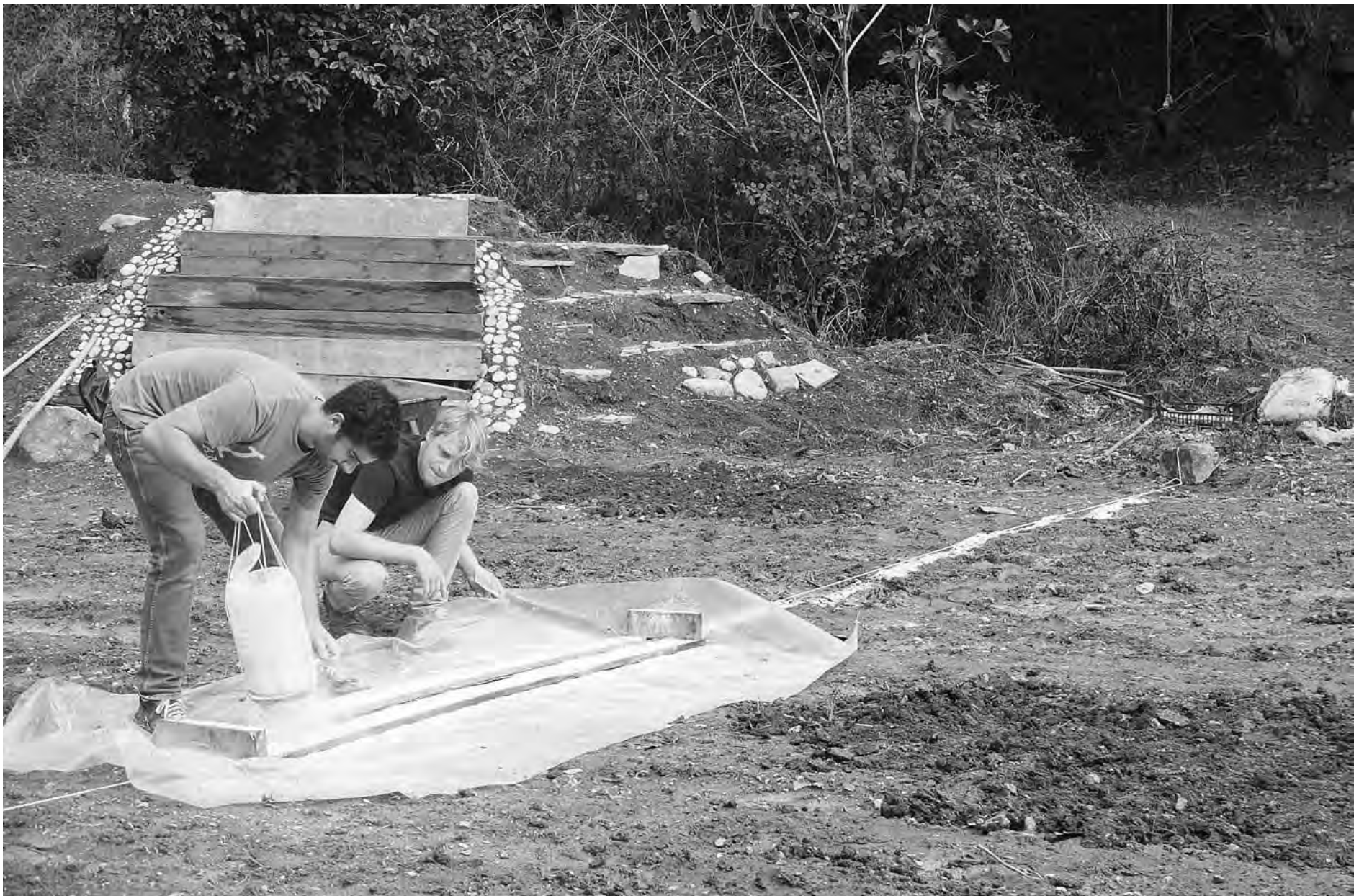
Öffentliche Gestaltungs- beratung Kuzgunzuk, Markieren des Spielfel- des mit improvisiertem „Kreidewagen“; Fotos: Studio Experimentelles Design
