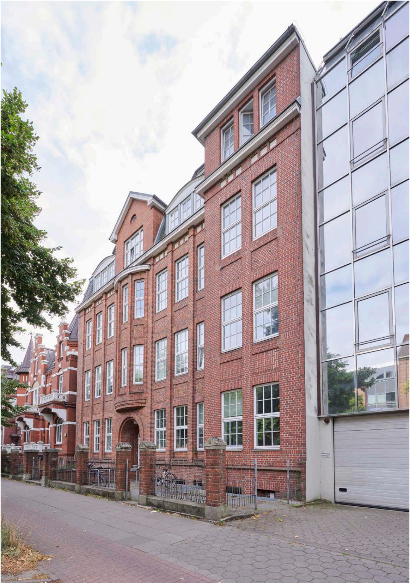
Eingang Gebäude Wartenau 15
