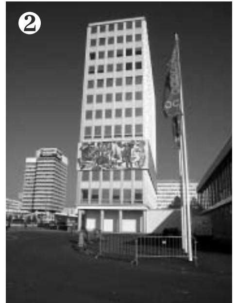
2 Haus des Lehrers, Westfassade (Bau Hermann Henselmann, 1961-64; Mosaikfries Walter Womacka)
