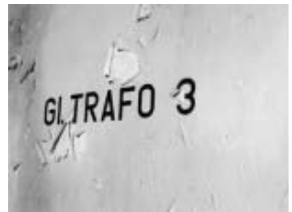
Ehemaliges Umspannwerk am Hallmarkt, Halle (Saale)
